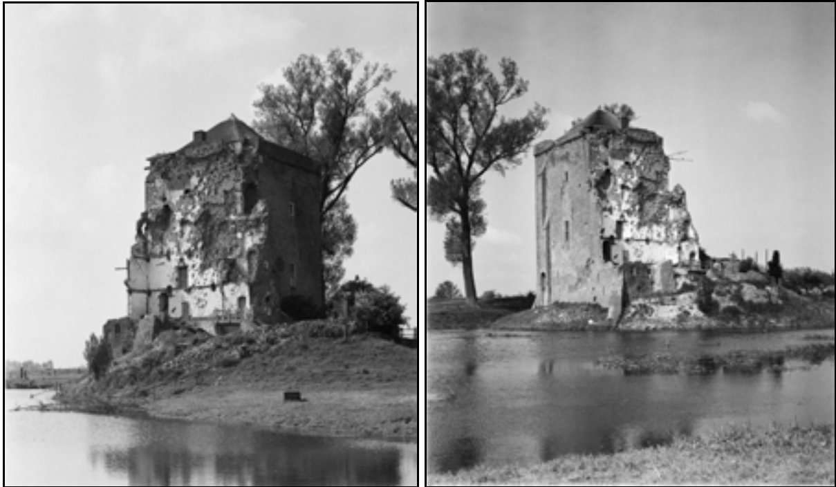
Links: kasteel De Nijenbeek vanuit het noordoosten in 1949 (fotocollectie Rijksdienst voor het Cultureel Erfgoed).
