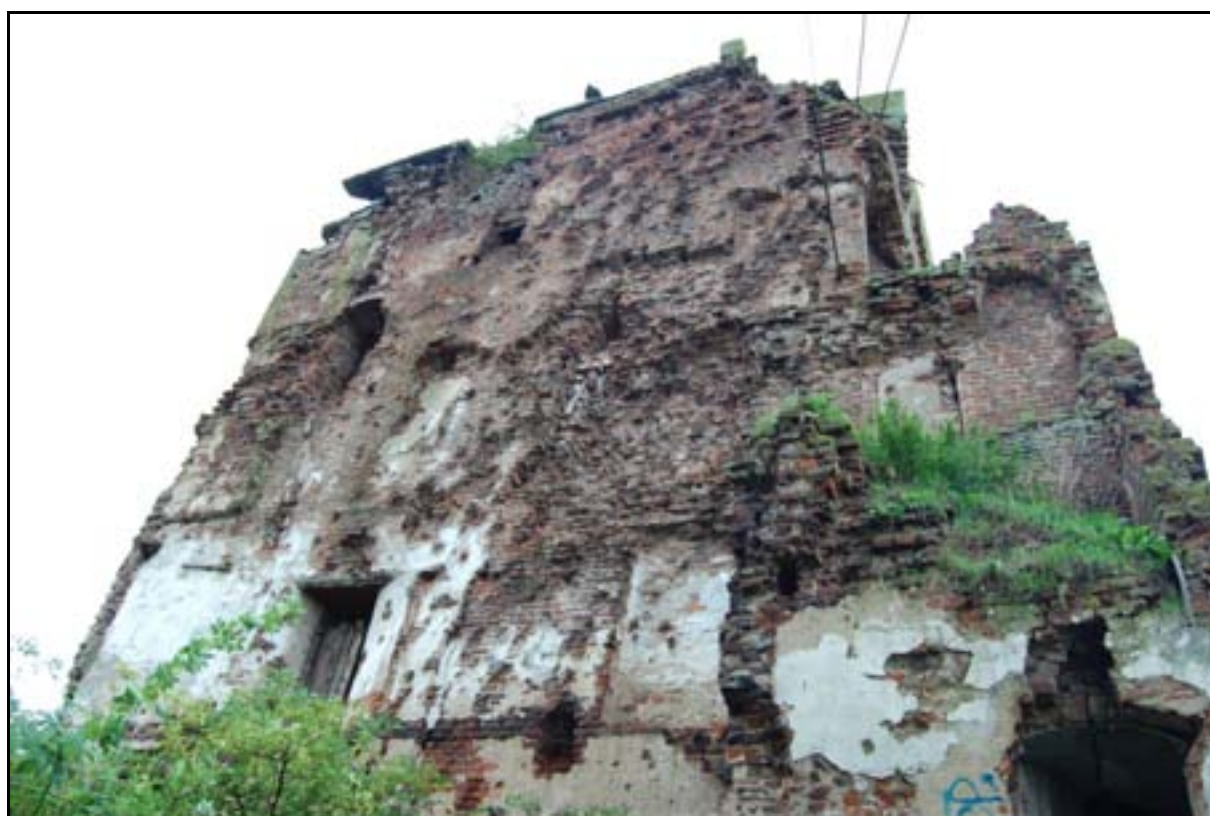
Overzicht van de oostgevel van de woontoren (links) en de traptoren (rechts).
