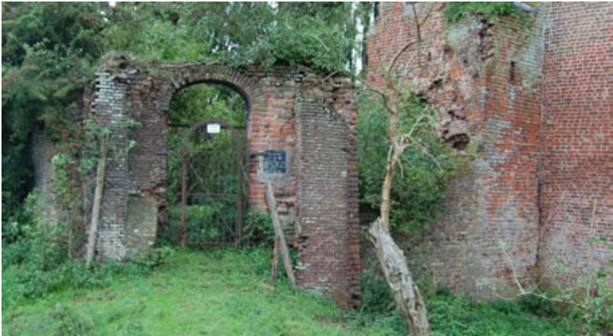
De voorzijde van de frontmuur van de voorburch. De poort heeft zijn huidige vorm gekregen bij de verbouwingen in de late 19 de eeuw. Bij de oorlogsvernievingen in 1945 is het fronton verdwenen.
