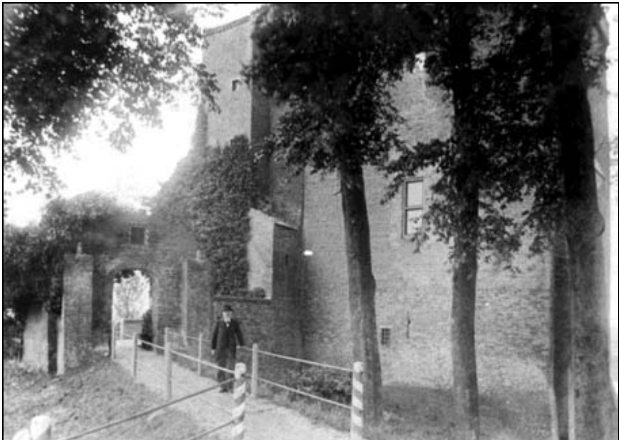
De noordgevel omstreeks 1900, na voltooiing van de restauratiewerkzaamheden en vernieuwing van de vensters (collectie Oudheidkundige Kring Voorst). Op deze foto vallen de toen recente inboetingen rondom het venster op de eerste verdieping goed te zien, evenals de dichtzetting erboven.
